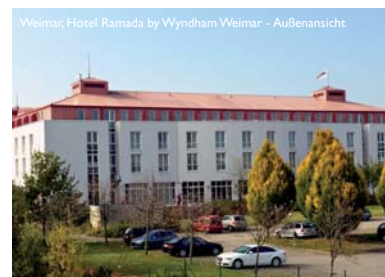
Weimar, Hotel Ramada by Wyndham Weimar - Außenansicht
