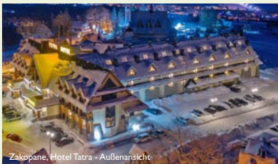
Zakopane, Hotel Tatra - Außenansicht
