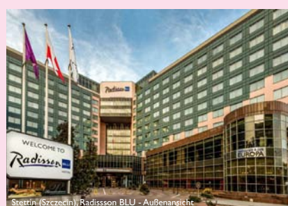
Stettin (Szczecin), Radisson BLU - Außenansicht
