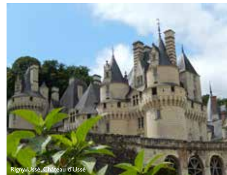
Rigny-Ussé, Château d'Ussé
