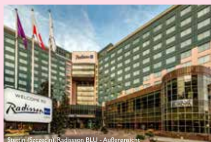
Stettin (Szczecin), Radisson Blu - Außenansicht
