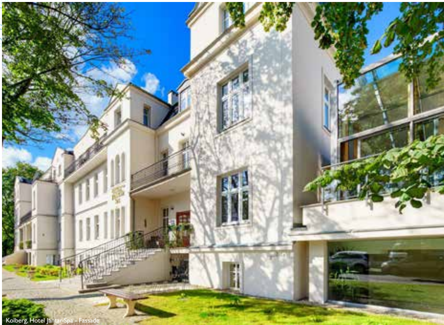
Kolberg, Hotel Jantar-Spa - Fassade
